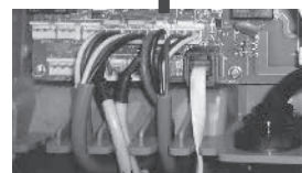
CABLAGGIO DI CONTROLLO PER MOTORI DI VENTILATORI
